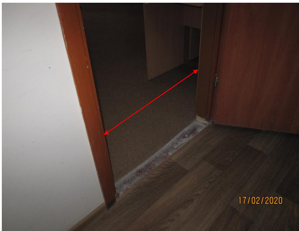
Рисунок 2.15 – Відсутність порогу для проходження МГН без перешкод. Ширина поєму 900мм
