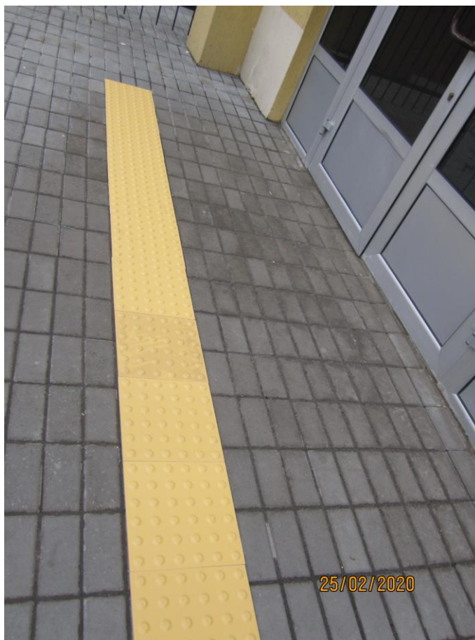
Рисунок 2.8 – Тактильна плитка перед вхідною групою для МГН
