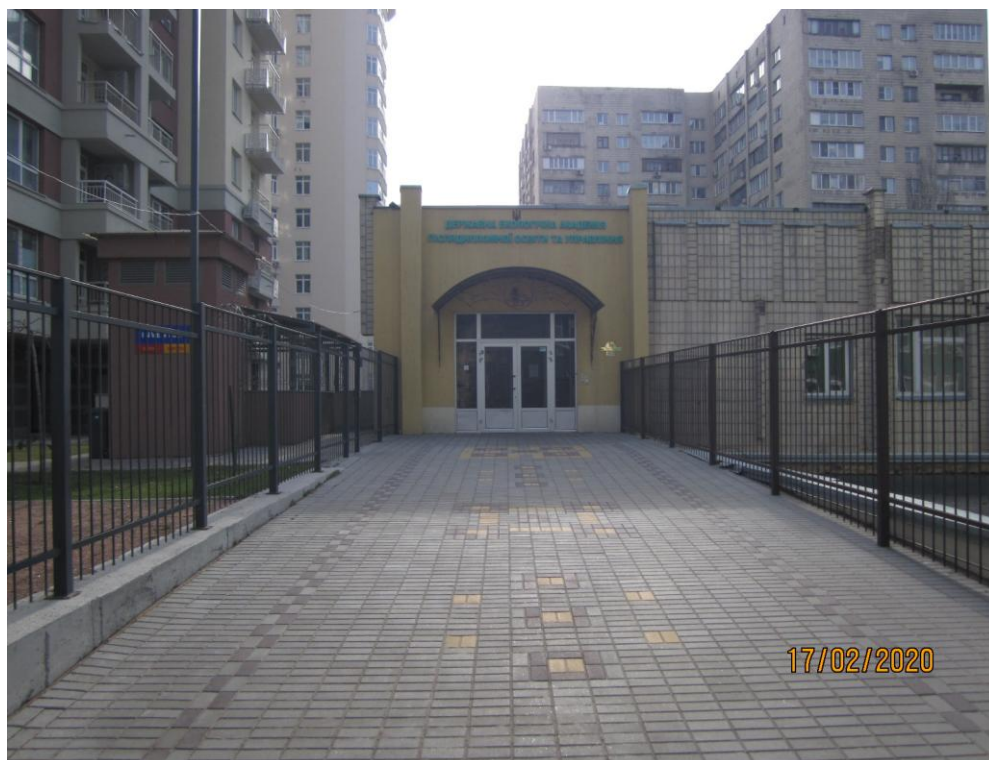
Рисунок 2.4 – Шлях до вхідної групи. Загальний вигляд вхідної групи до будівлі.
