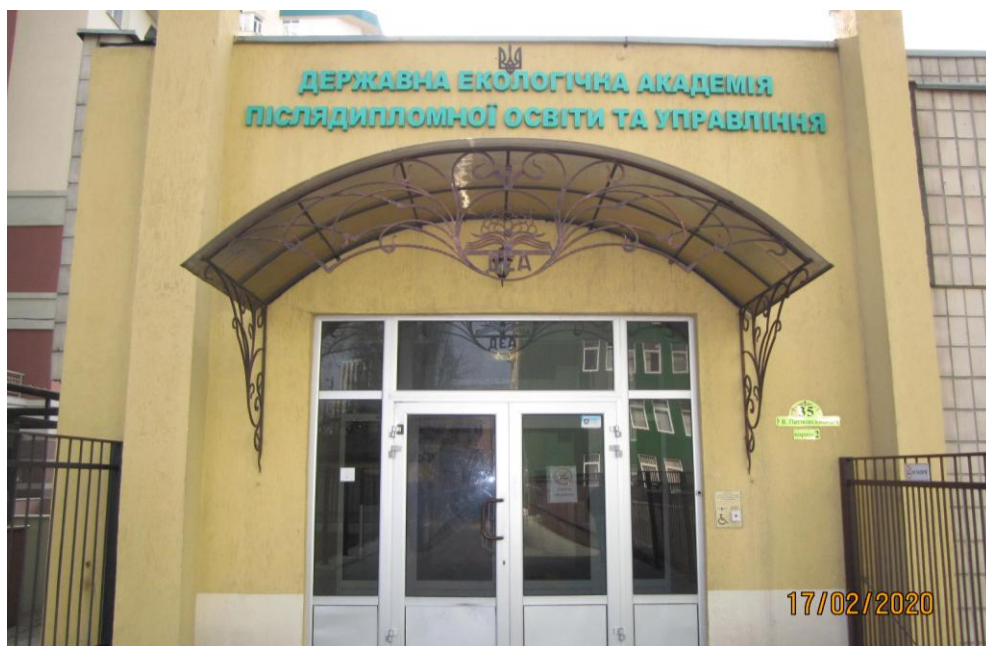
Рисунок 2.6 – Загальний вигляд вхідної групи Державної екологічної академії післядипломної освіти та управління. Вхід з навісом, розпашні двері (1800x2008)
