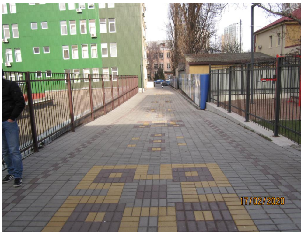
Рисунок 2.5 – Шлях з вулиці Митрополита Василя Липківського до корпусу 2. Кут 8%
